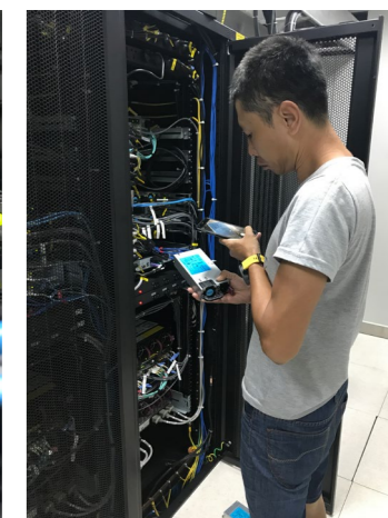
维修人员对故障机器进行记录和维修
